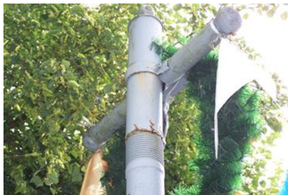
Zwieńczenie krzyża z widoczną łuską oraz gwintem. Widok od północy.
