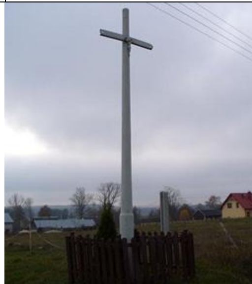
Widok ogólny krzyża od strony Północnej. Stan przed przebudową.
